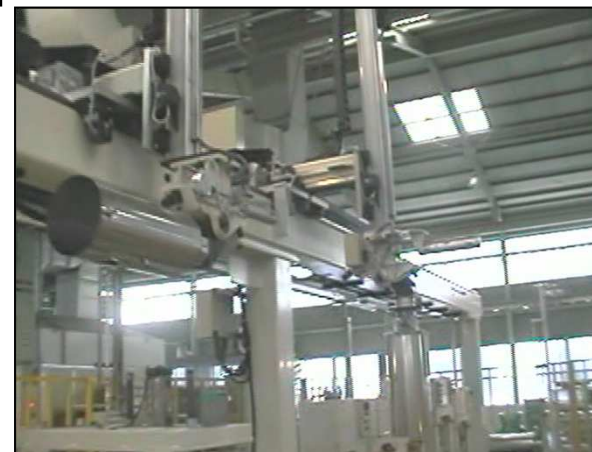
住宅設備関連(給湯器組立)
