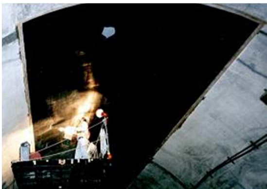
国道トンネル補修
