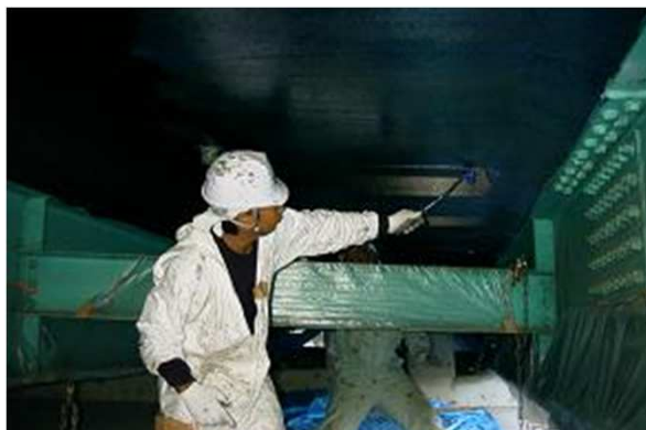
橋のRC床版補強
