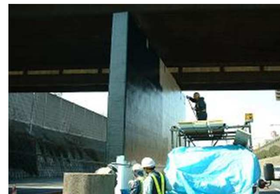
橋の壁式橋脚補強
